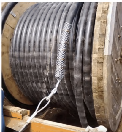
Рисунок 1 – Протяжка кабеля с использованием кабельного чулка
