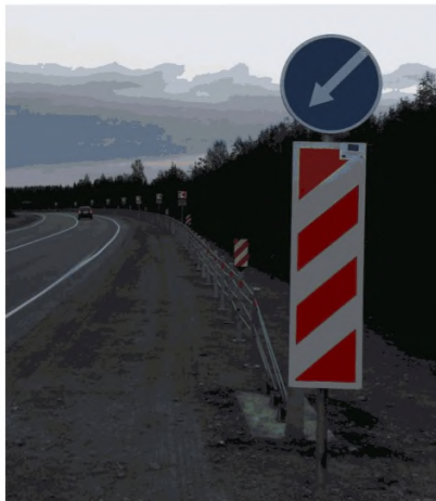
Рисунок 15– Установка тросового ограждения на обочине
