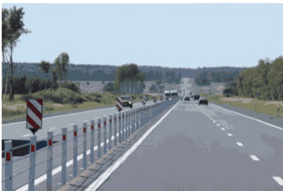
Рисунок 16 - Установка тросового ограждения на оси проезжей части
