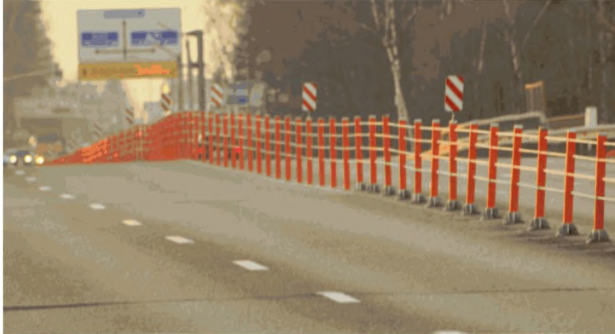
Рисунок 17 - Установка тросового ограждения на мостовом сооружении
