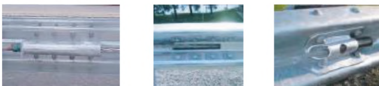
Рисунок 13 - Крепления троса к балке барьерного ограждения
