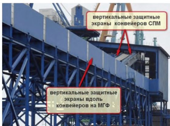
Рисунок 56 – ТКС с боковой ветропылезащитой
