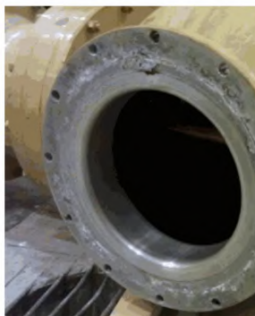
Рисунок 4 - нагрев болтового соединения объемов КРУЭ
