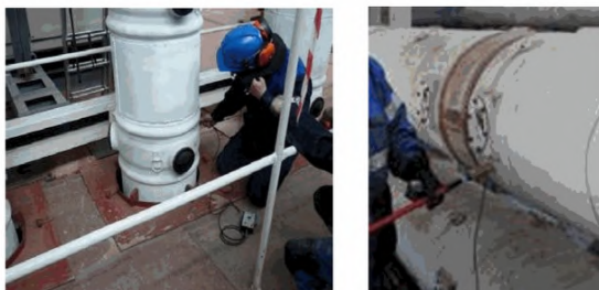
Рисунок Д.2 – Установка акустического датчика на кожух экранированного токопровода
