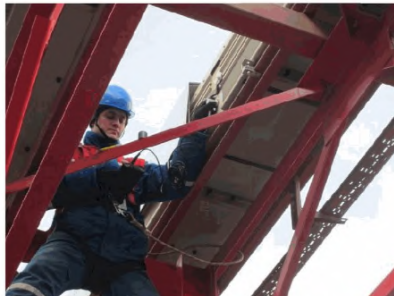
Рисунок Д.3 – Установка акустического датчика на кожух токопровода ТКЛ
