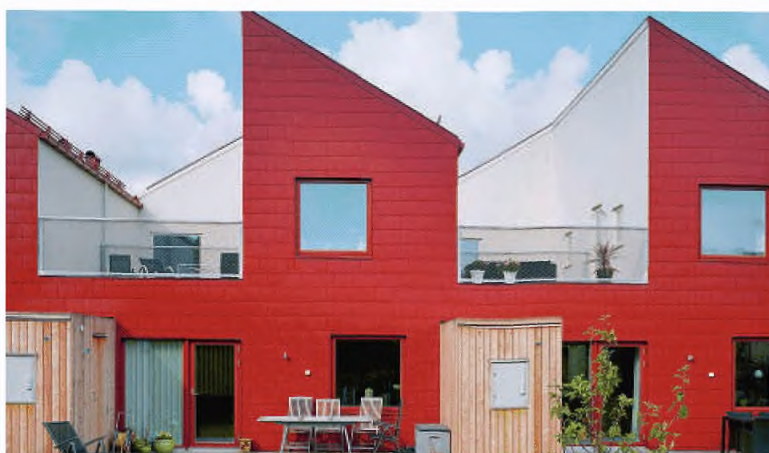
Гетеборг, Швеция © Kalle Sanner / White Architects
