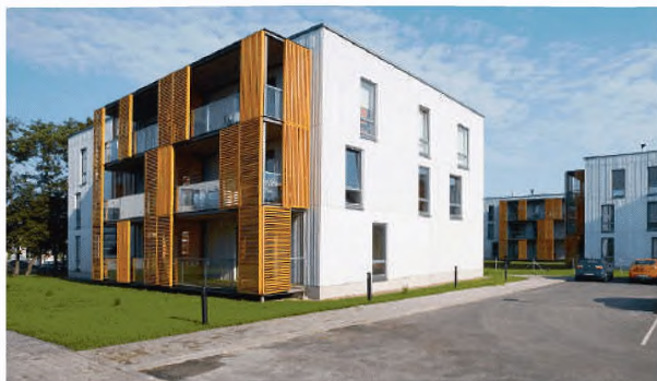
Таллин, Эстония © JVR Arhitektuuribüroo
