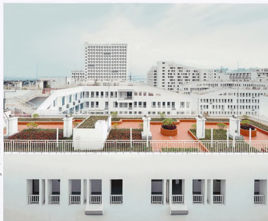
Сгруппированные выходы инженерных коммуникаций на эксплуатируемой крыше Longnan Garden Social Housing Estate (Сюйхуэй, Китай)
