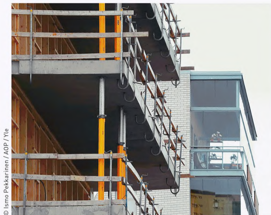
Внешняя стена и балконы из монолитного железобетона
