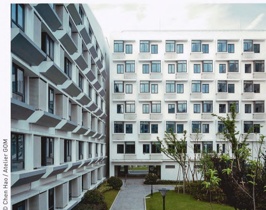
Корзины для кондиционеров на фасаде Longnan Garden Social Housing Estate (Сюйхуэй, Китай)
