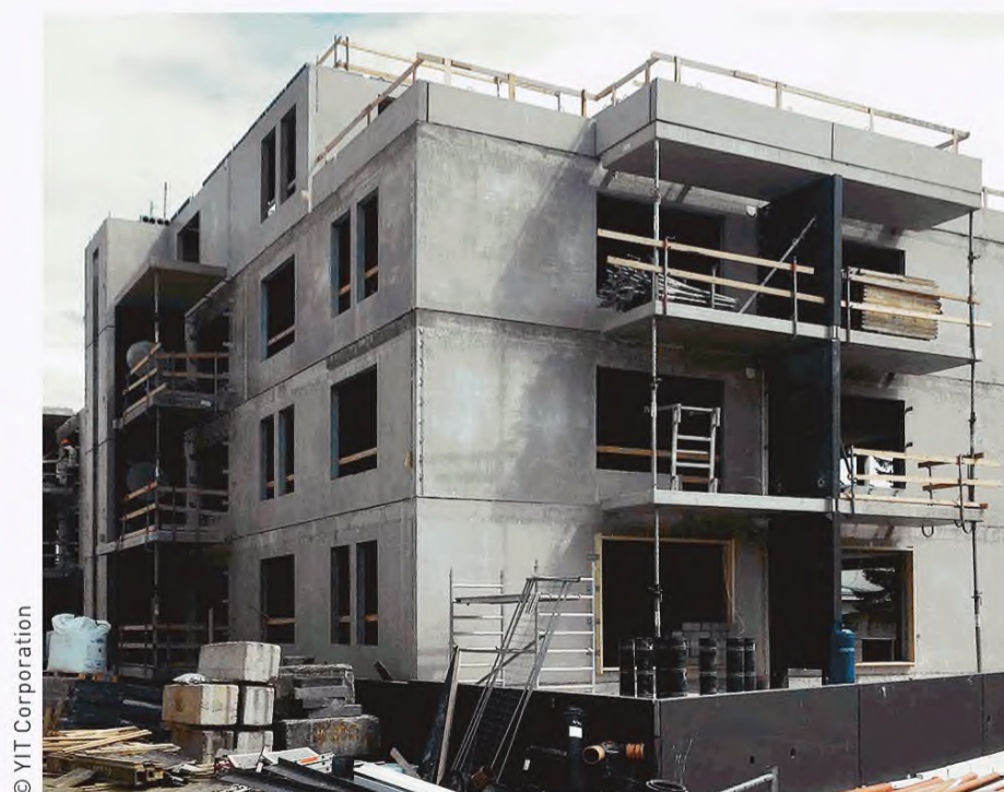
Железобетонные панели
