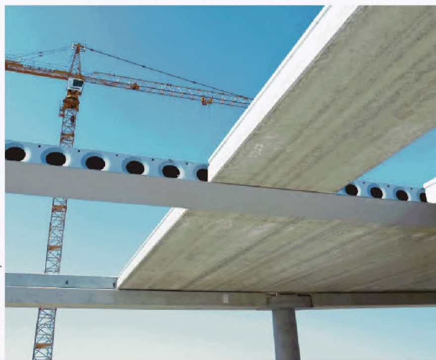
Сборные железобетонные конструкции
