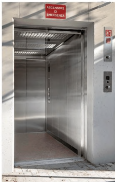
Рисунок 103 – Пример лифта для транспортирования пожарных подразделений с габаритами больничного лифта
