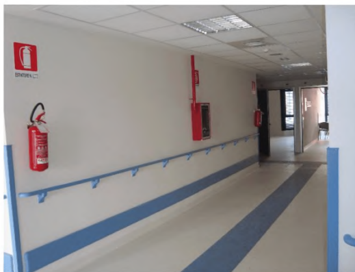
Рисунок 99 – Пример оборудования палатного отделения первичными средствами пожаротушения
