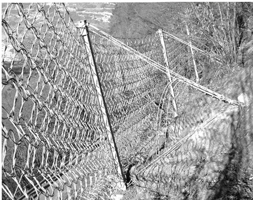
Рисунок А.2 – Пример противокаменного барьера из кольчужной сети (фотография с сайта компании «Гео-Барьер» http://www.geobarrier.ru/projects )
