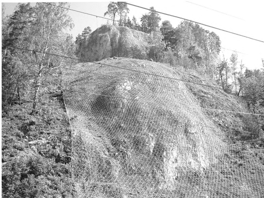
Рисунок А.1 – Пример противокаменной завесы из кольчужной сети (фотография с сайта компании «Гео-Барьер» http://www.geobarrier.ru/projects )
