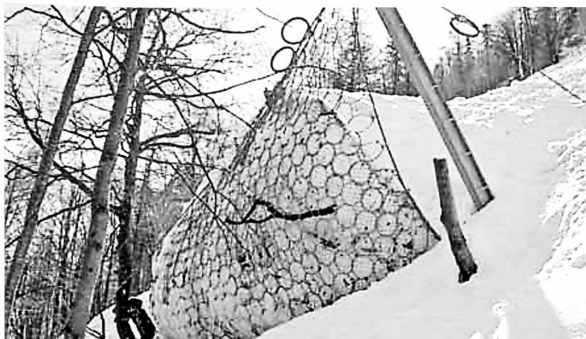
Рисунок А.4 – Пример конструкции снегоудерживающего барьера.
