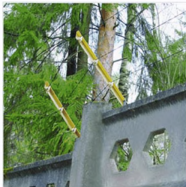
Рисунок 2.52 – ЧЭ комбинированного проводного извещателя «Дуэт»
