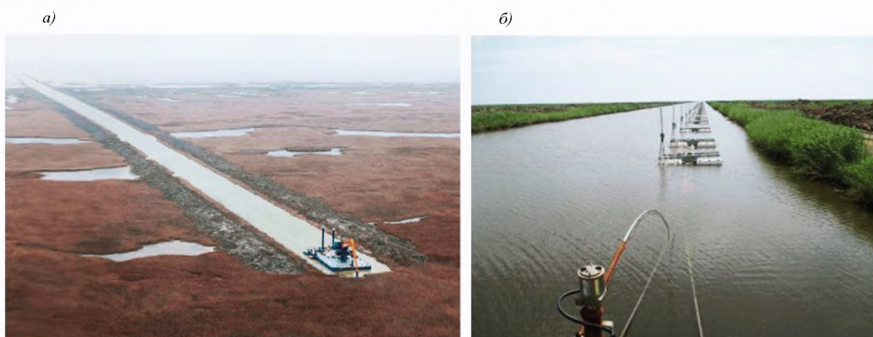
Рис. 10.2-2 Грейферный земснаряд «Титан» при разработке траншеи (а) и протаскивание на плаву трубопровода с берега (б)
