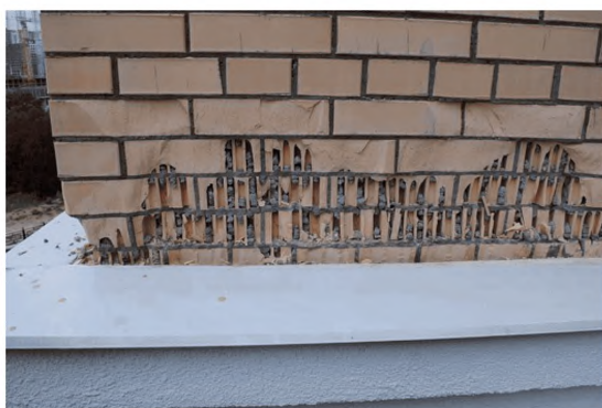
Рисунок А.1.13. Разрушение кладки облицовочного каменного слоя в результате ее размораживания
