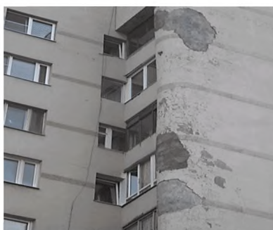
Рисунок Б.6. Оштукатуривание поврежденного облицовочного слоя
