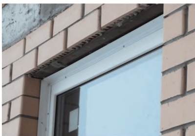
Рисунок 12.3. Зоны проникновения воды в кладку стен через не герметизированные зоны примыкания оконных блоков и водоотливов к стеновому проему
