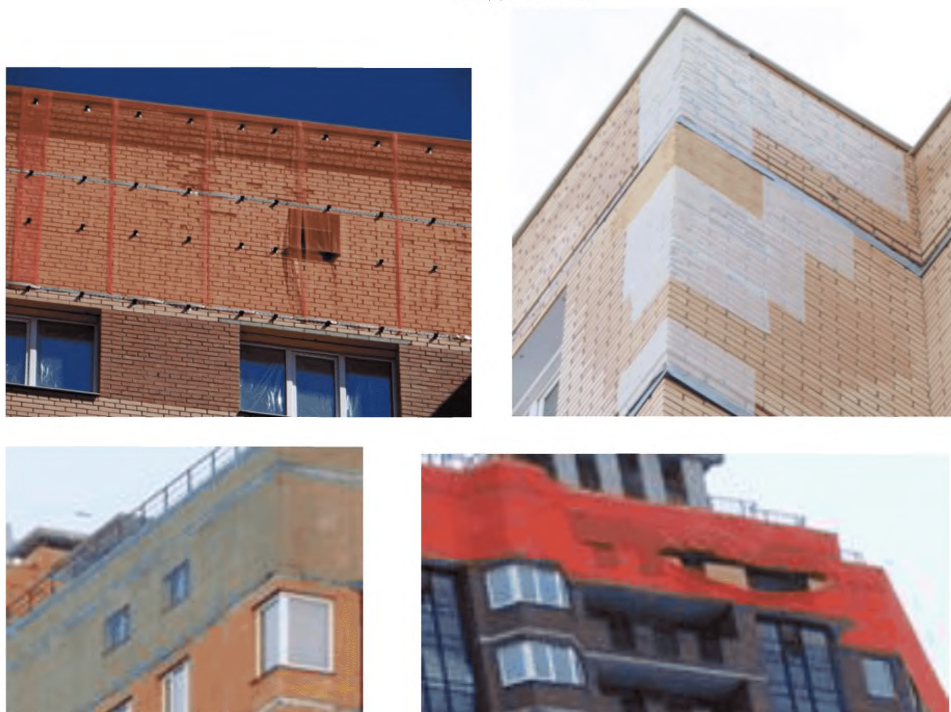
Рисунок Б.9. Защита поврежденного облицовочного каменного слоя сэндвич – панелями с низкой паропроницаемостью и высокой деформативностью при внешних температурных воздействиях
