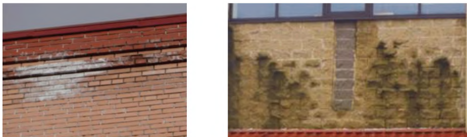
Рисунок А.1.16. Образование высолов и потемнений на поверхности каменного облицовочного слоя
