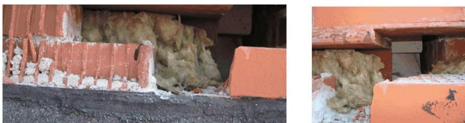
Рисунок А.2.6. Некачественный монтаж слоя теплоизоляции
