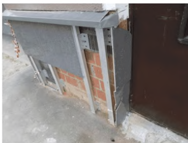
Рисунок В.3. Разрушения облицовки из керамогранита в цокольной части здания из-за механических воздействий
