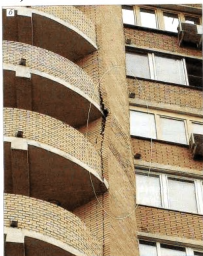
Рисунок А.1.2. Выпучивание облицовочного слоя из-за отсутствия горизонтальных деформационных швов, отсутствия либо недостаточного количества гибких связей:
