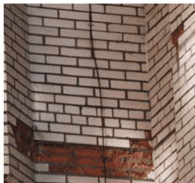
Рисунок А.1.13. Разрушение кладки облицовочного каменного слоя в результате ее размораживания
