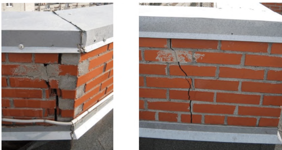
Рисунок А.1.9. Трещины в каменных парапетах кровли из-за отсутствия или недостаточного армирования кладки, отсутствия вертикальных деформационных швов
