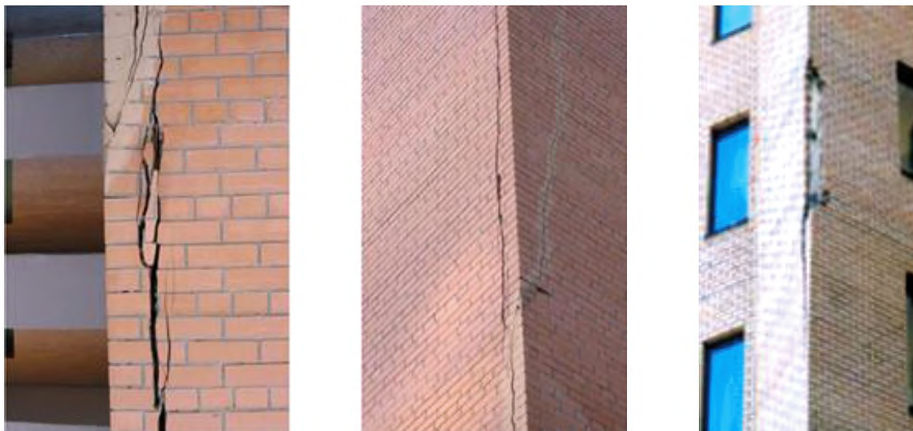
Рисунок А.1.3. Образование вертикальных и/или наклонных трещин в угловых зонах из-за отсутствия или недостаточного их армирования, отсутствия вертикальных деформационных швов
