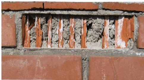
Рисунок А.2.2. Заполненные строительным раствором щели пустотных кирпичей
