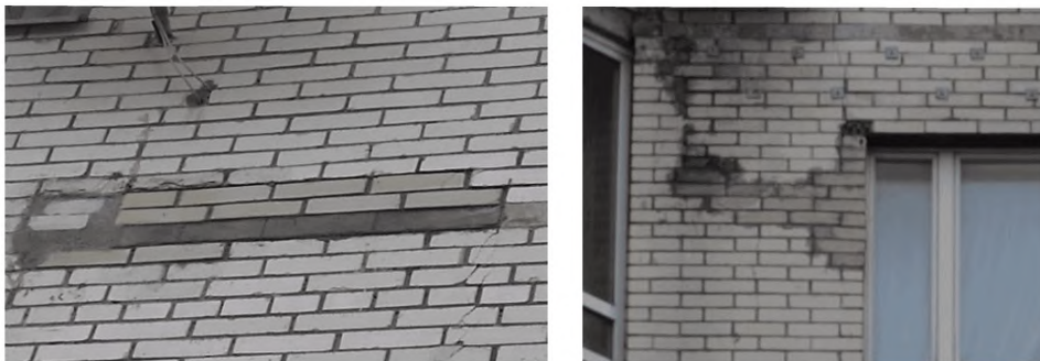
Рисунок Б.4. Ремонт облицовочного слоя с докомпановкой (заменой) разрушенных участков кладкой, отличающейся физико-механическими свойствами и цветом от основной кладки, без устранения причины разрушений или усиления фасада
