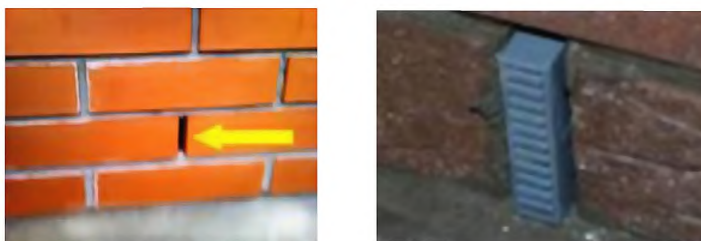
Рисунок 13.2 Устройство вентиляционных продухов в растворных швах
