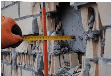
Рисунок А.1.11. Раздробление каменной кладки в уровне междуэтажных перекрытий с неполным опиранием облицовочного слоя (с транзитными участками) из-за отсутствия горизонтальных деформационных швов
