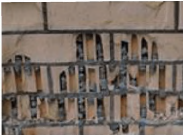
Рисунок А.2.2. Заполненные строительным раствором щели пустотных кирпичей
