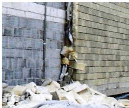
Рисунок А.1.1 Обрушение облицовочного каменного слоя из-за его недостаточного опирания, отсутствия горизонтальных деформационных швов, отсутствия либо не достаточного количества гибких связей: а – на участках с железобетонным внутренним слоем, б – на участках с каменным внутренним слоем
