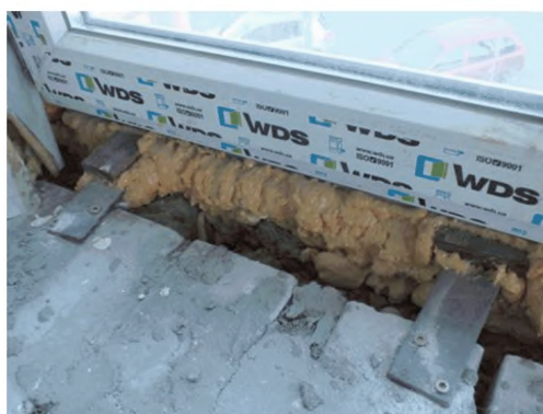
Рисунок А.2.6. Некачественный монтаж слоя теплоизоляции
