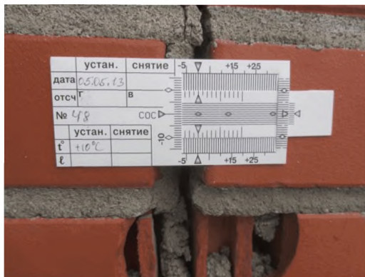
Рисунок 6.1 Пример измерения ширины раскрытия трещин фиксирующим устройством пластинчатого типа
