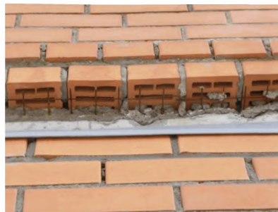
Рисунок А.2.2. Заполненные строительным раствором щели пустотных кирпичей
