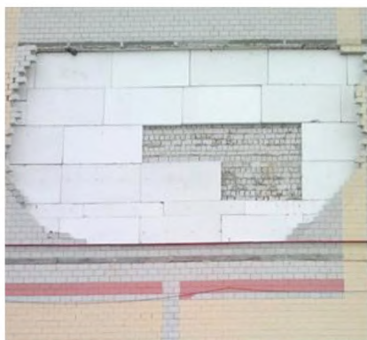
Рисунок А.1.1 Обрушение облицовочного каменного слоя из-за его недостаточного опирания, отсутствия горизонтальных деформационных швов, отсутствия либо не достаточного количества гибких связей: а – на участках с железобетонным внутренним слоем, б – на участках с каменным внутренним слоем
