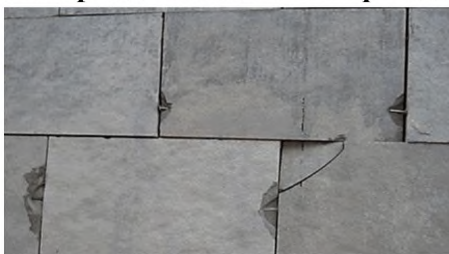
Рисунок В.1. Разрушение керамогранитной облицовки в местах штыревых креплений
