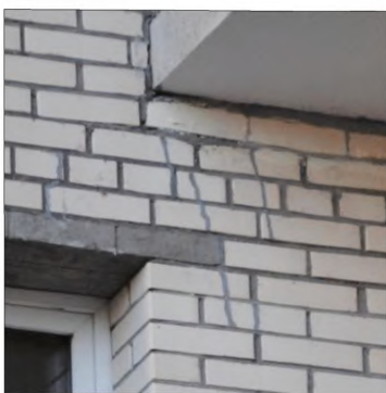
Рисунок А.1.6. Вертикальные и наклонные трещины на прямых участках стен в угловых зонах оконных проемов вследствие различных деформаций кладки в межоконных поясах и простенках и отсутствия ее армирования
