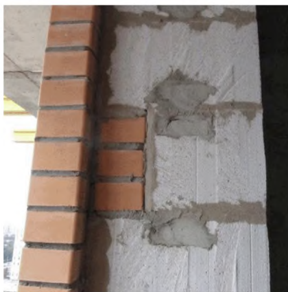
Рисунок А.2.8. Отсутствие вентилируемой воздушной прослойки между облицовочным слоем и внутренним слоем из газобетонных блоков
