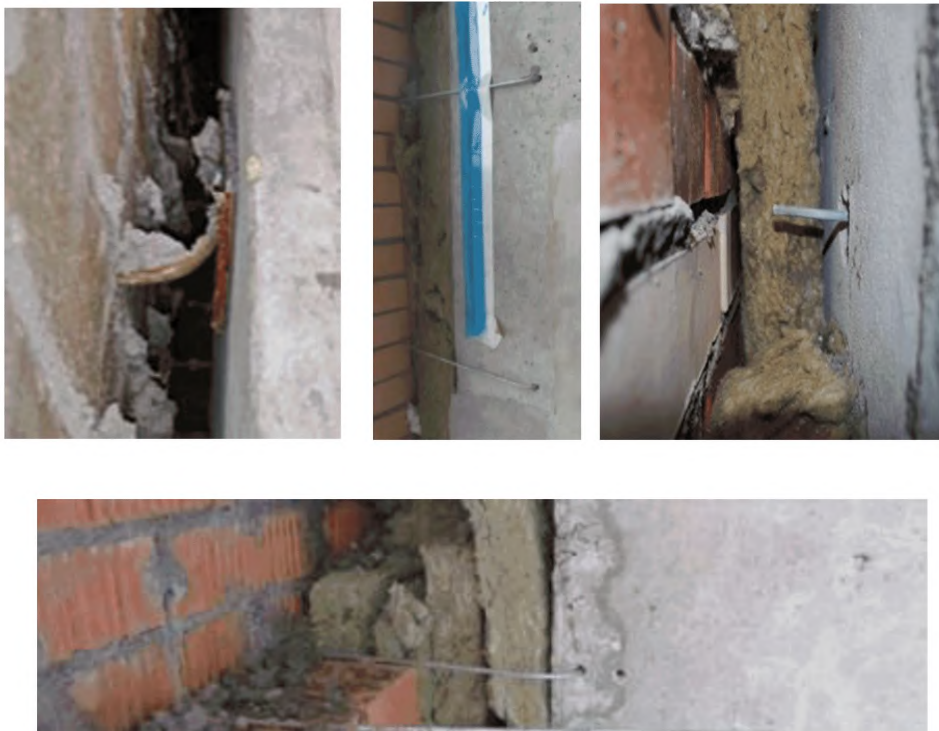
Рисунок А.2.5. Ненадежное крепление лицевого каменного слоя к внутренней железобетонной стене с помощью гибких связей
