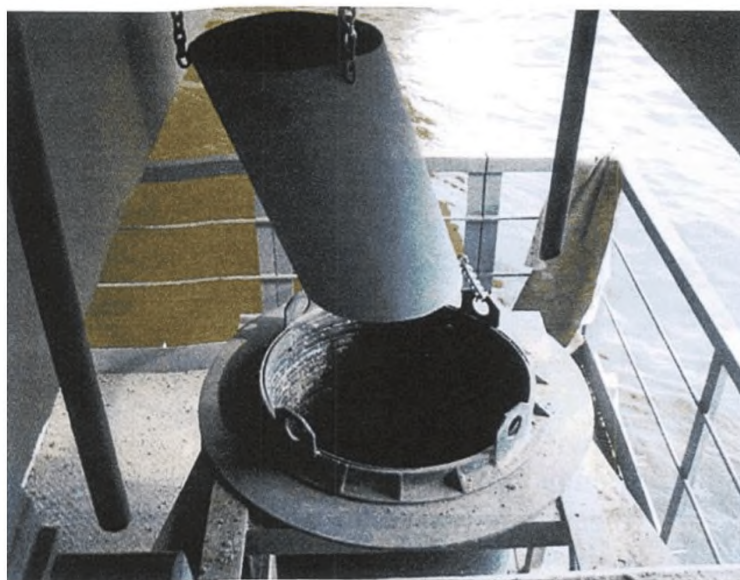
Рисунок В.7 – Установка фильтрующего патрона на опору моста
