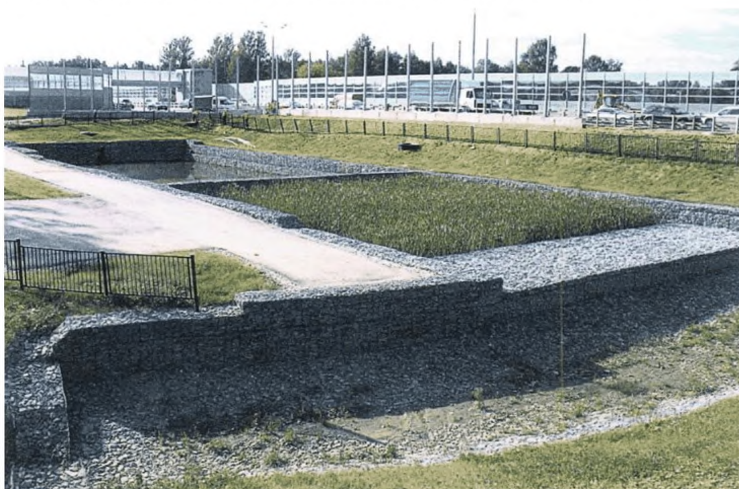
Рисунок В.2 – Очистное сооружение каскадного типа с использованием габионов (вид сбоку)
