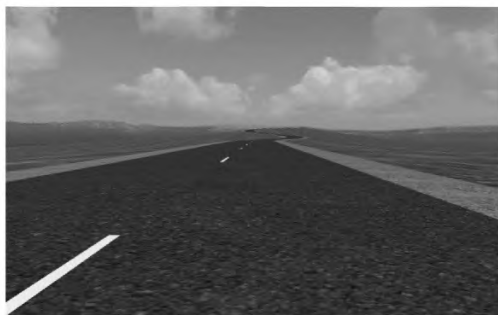
Рисунок 22 – Извилистость дороги, вызванная превышением числа углов поворота в плане над числом переломов в продольном профиле
