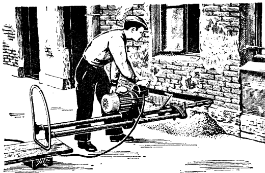
Рис. IV.28. Общий вид установки для разрезания кирпичной стены
