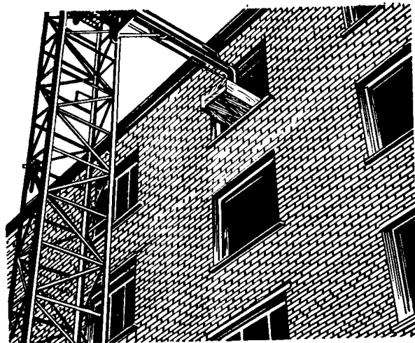
Рис. 1.23. Подача строительным подъемником СП-06 в оконный проем контейнера со строительными изделиями и материалами
