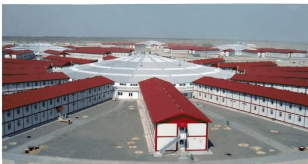
Рисунок 5.17 – Комплекс модульных зданий административно-бытового назначения
