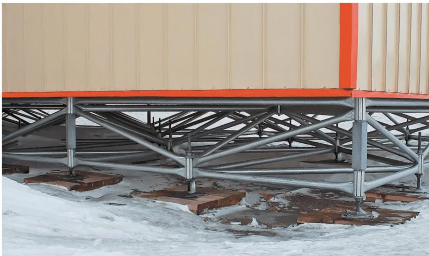
Рисунок 5.2.3 – Установка блок-контейнеров на вечной мерзлоте
