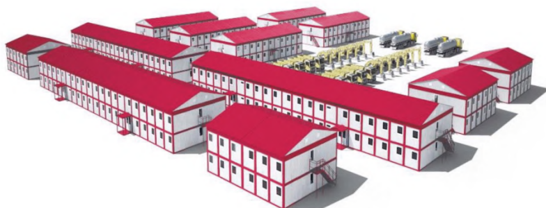
Рисунок 5.18 – Жилой поселок из модульных зданий
