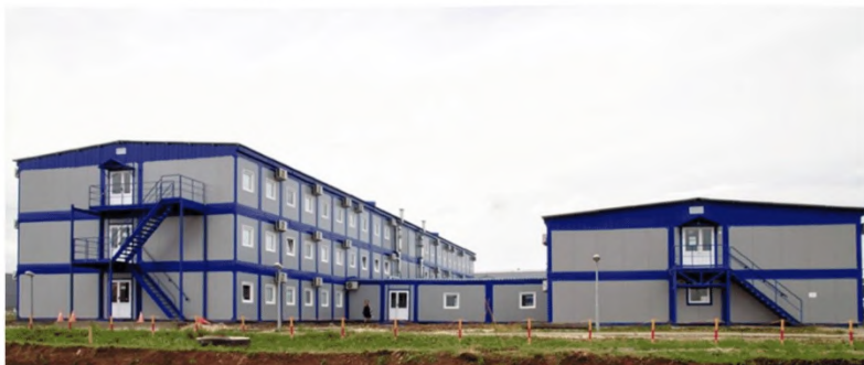
Рисунок 5.16 – Комплекс модульных зданий жилого и административно-бытового назначения
