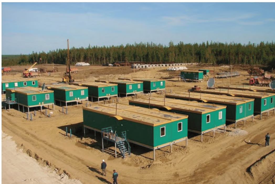
Рисунок 5.3.2 – Строительство вахтового поселка
