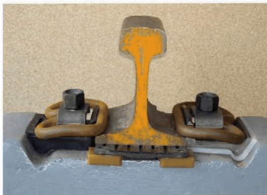
Рисунок 6.8 – Скрепление типа ЖБР-65Ш
