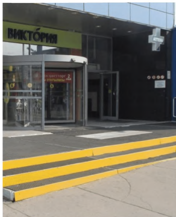
Рисунок 6.24 – Неправильная маркировка: выделен цветом только подступенок
