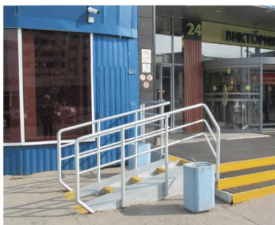
Рисунок 6.30 – Недопустимые конструкции входных пандусов для инвалидов
