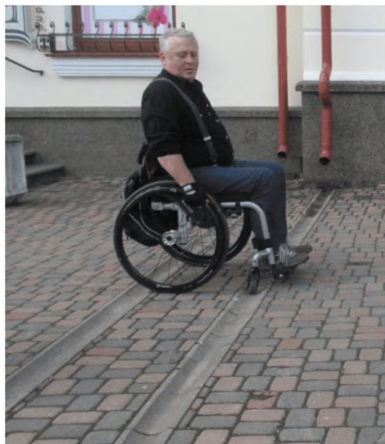
Рисунок 5.26 – Глубокие узкие открытые лотки на путях движения инвалидов недопустимы
