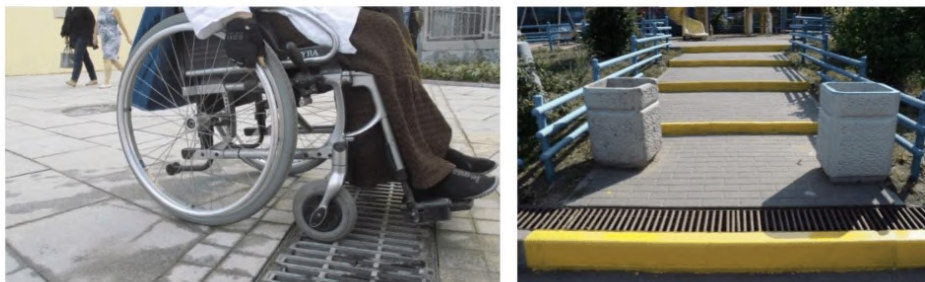
Рисунок 5.23 – Возможно застревание колес в продольных отверстиях решетки
