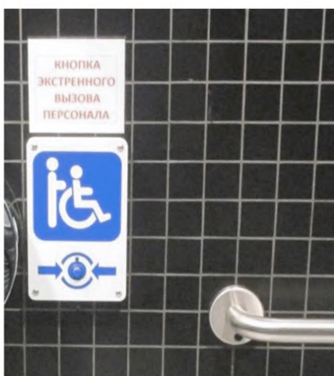
Рисунок 9.16 – Примеры систем сигнализации в санузле для инвалида
