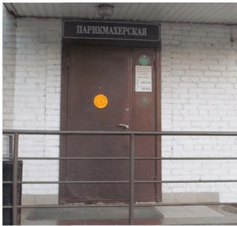
Рисунок 6.63 – Примеры ошибочной маркировки желтым кружком
