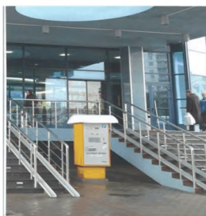
Рисунок 6.30 – Недопустимые конструкции входных пандусов для инвалидов
