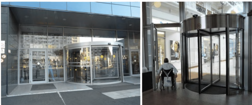
Рисунок 6.67 – Примеры применения вращающихся дверей с дублирующим проходом через распашную дверь
