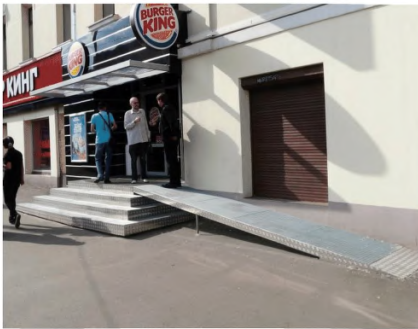
Рисунок 6.40 – Недопустимые решения по установке поручней на пандусе
