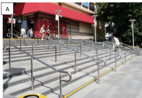
Разделительные поручни выполнены по нормативу, маркировка ступеней выполнена неправильно
