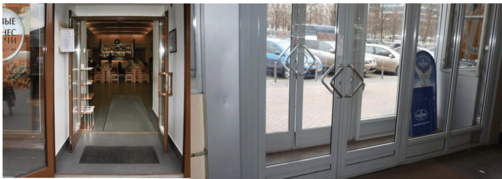
Рисунок 6.70 – Примеры тамбуров, через которые проход на кресле-коляске будет невозможен без помощи сопровождающего
