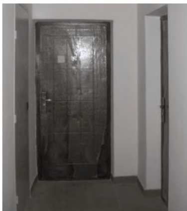
Доступа к ручке затруднен для человека на кресле-коляске
