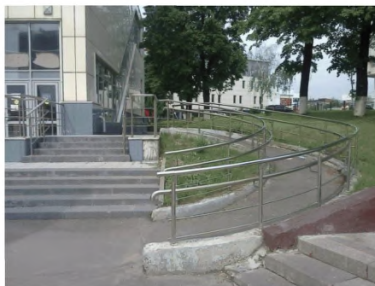
Рисунок 6.42 – Винтовые (криволинейные) пандусы применять не рекомендуется
