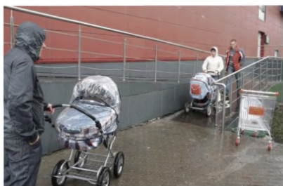
Рисунок 6.27 – При интенсивном движении предпочтительны широкие пологие пандусы, обеспечивающие возможность двустороннего движения
