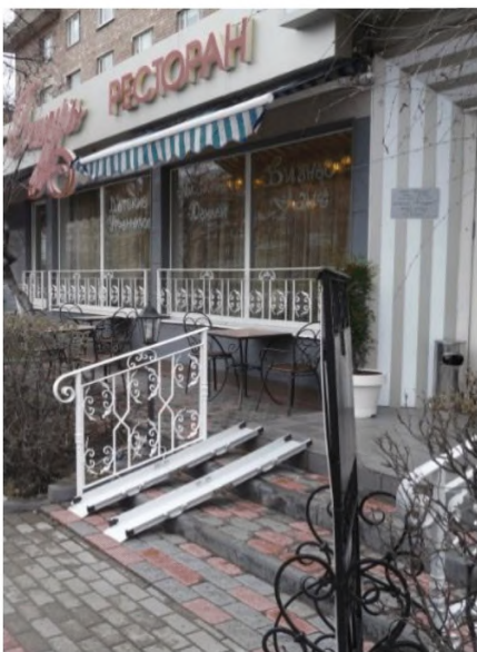
Рисунок 6.31 – Недопустимые на путях движения инвалидов конструкции (аппарели)
