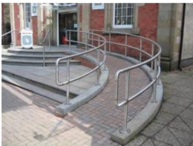
Рисунок 6.42 – Винтовые (криволинейные) пандусы применять не рекомендуется
