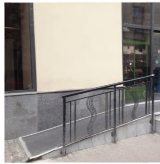
Рисунок 6.40 – Недопустимые решения по установке поручней на пандусе
