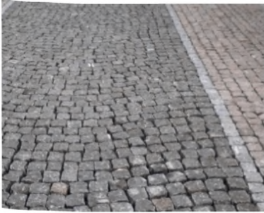
Рисунок 5.2 – Некомфортные для инвалидов виды покрытий пешеходных путей движения
