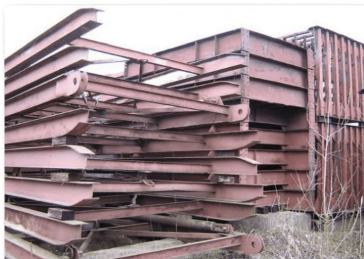
Рисунок 5 – Пример складирования конструкций аванбека моста
