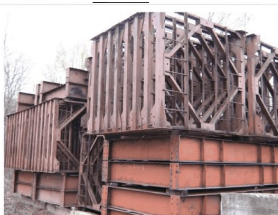
Рисунок 6 – Пример складирования элементов надстройки промежуточных опор моста
