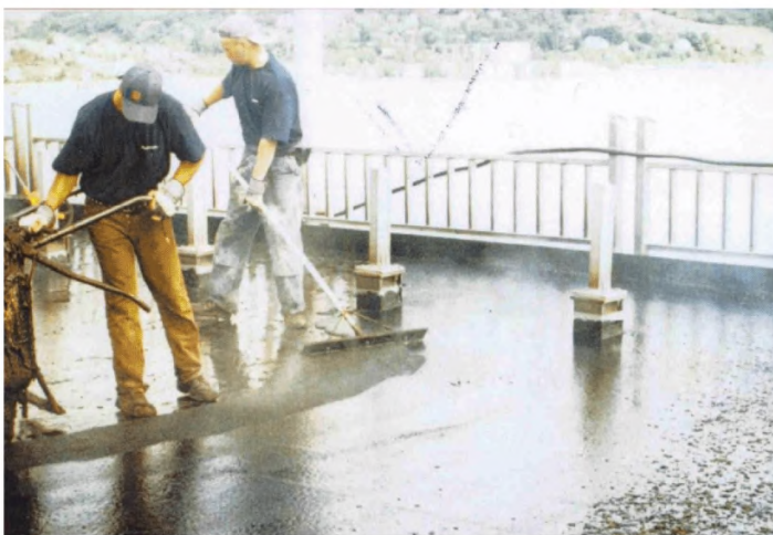
Рисунок В.11 - Укладка гидроизоляционной мастики по полимербитуму
