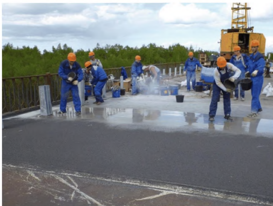
Рисунок В.20 - На заднем плане нанесение основного износостойкого слоя «Matacyl WL®», на переднем плане присыпка еще не полимеризовавшегося слоя корундом, работы идут одновременно
