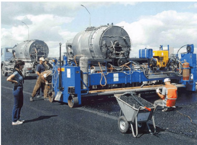
Рисунок В.7 - Асфальтоукладчик и котлы «кохеры»
