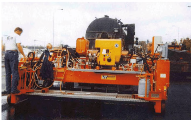
Рисунок В.13 - Укладка литого полимерасфальтобетона типа I по асфальтобетону А
