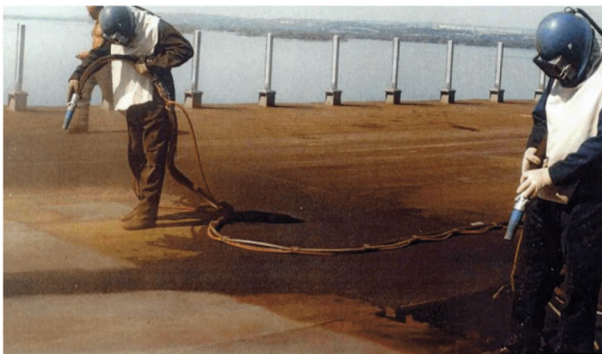
Рисунок В.8 - Пескоструйная очистка поверхности ортотропной плиты
