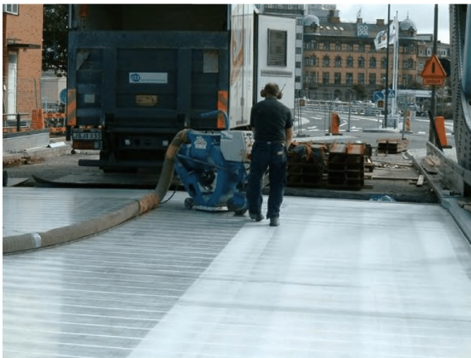
Рисунок В.15 - Подготовка поверхности шлифовальными машинами с металлическими щетками, снабженными пылесосами
