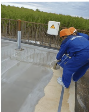
Рисунок В.19 - Нанесение основного износостойкого слоя «Matacyl WL®»
