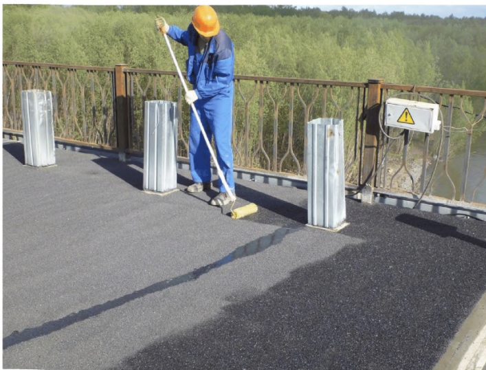
Рисунок В.21 – Нанесение финишного лака «Matacyl STC®»
