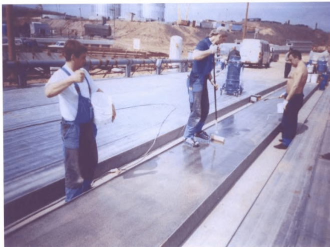
Рисунок В.16 – Нанесение праймера «Matacyl Primer CM®», присыпка песком
