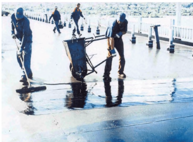
Рисунок В.10 - Разлив полимербитума по разжиженному полимербитуму
