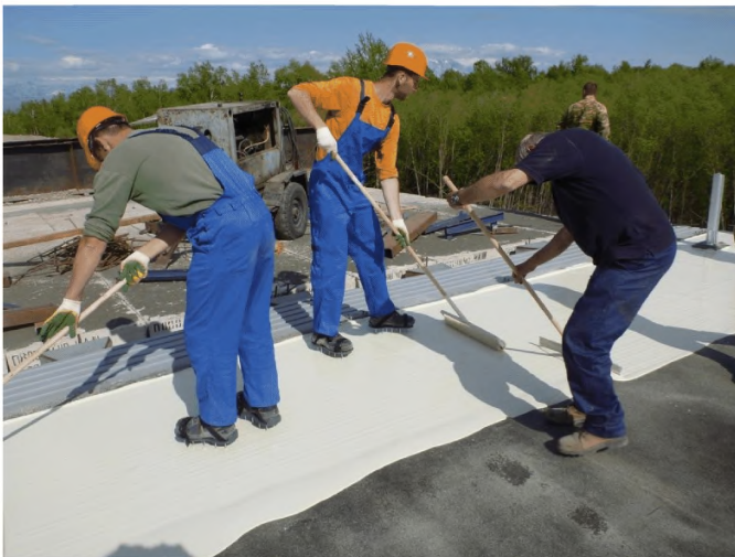
Рисунок В.17 - Нанесение демпфирующего слоя – мастики «Matacryn Manual®»
