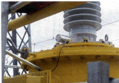
Рисунок В.6 – Использование емкостей ввода в качестве соединительного конденсатора через ПИН-вывод
