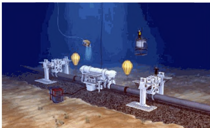
Рис. 12.2.1 Ремонтная система трубопровода Nord Stream с использованием гипербарической сварки Hyperbaric Welding System
