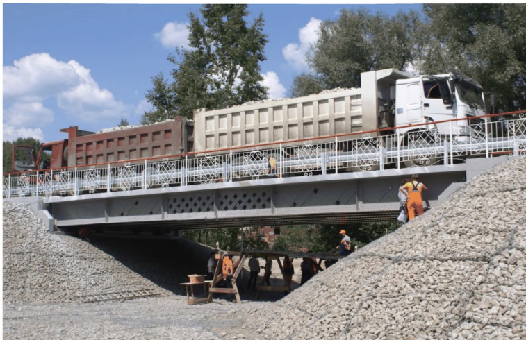
Рисунок В.12 – Испытание моста
