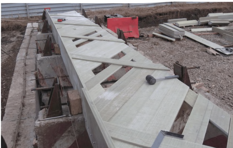
Рисунок В.4 – Сборка фермы на монтажном столе
