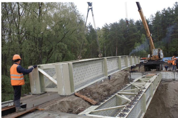
Рисунок В.8 – Установка монтажного блока в пролет
