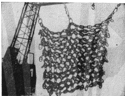
Рис. 7. Укрытия из якорных цепей
