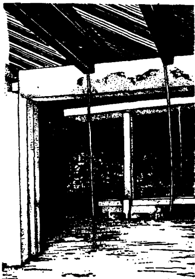
Рис. 6. Висячие земляные термитные трубки в подполье здания.
