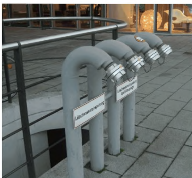
Рисунок 22 – Пример установки соединительных головок снаружи здания
