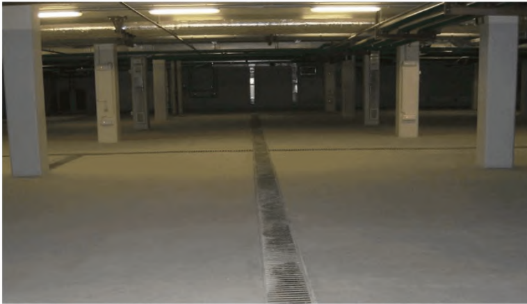
Рисунок 13 – Расположение дренажных лотков в полу нижнего уровня стоянки автомобилей
