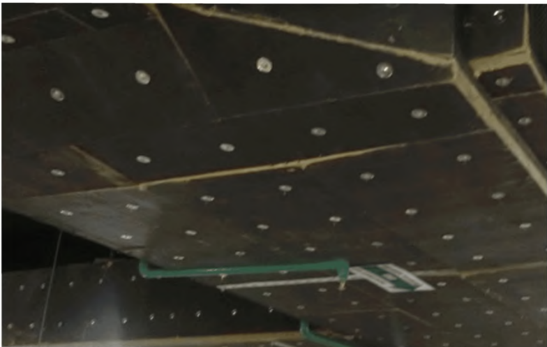
Рисунок 21 – Расположение спринклерных оросителей под воздуховодами дымоудаления
