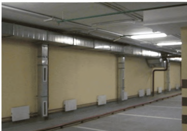
Рисунок 7 – Фрагмент стоянки автомобилей с приборами отопления и разводкой вентиляции
