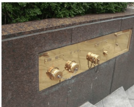
Рисунок 22 – Пример установки соединительных головок снаружи здания
