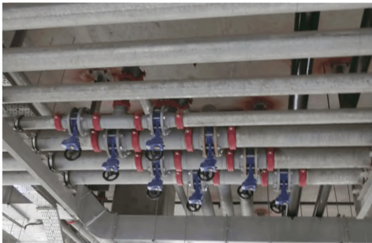
Рисунок 5 – Вид стоянки автомобилей с инженерными сетями (грувлочные соединения)
