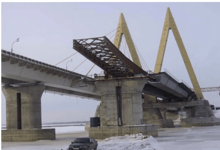
Рисунок Б.2 – Строительство моста «Миллениум»
