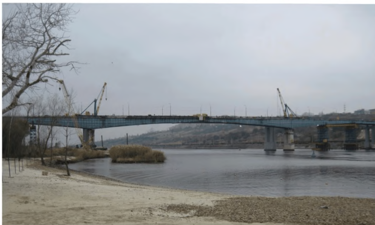
Рисунок Б.17 – Демонтаж Аксайского моста
