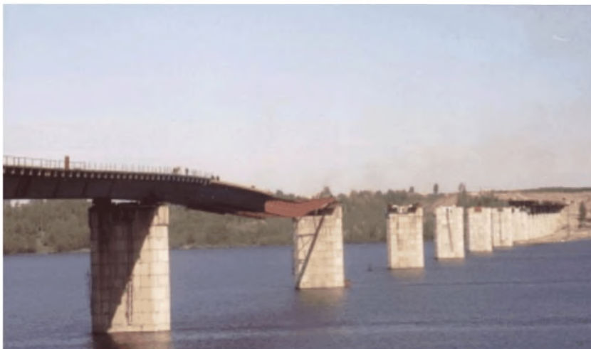
Рисунок Б.1 – Строительство моста через р. Волгу в г. Кинешма
