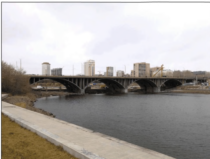
Рисунок Б.21 – Реконструкция Макаровского моста в г. Екатеринбурге
