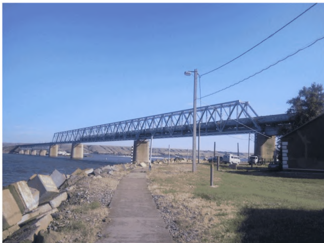
Рисунок Б.14 – Общий вид железнодорожного моста через р. Дон в Волгоградской области
