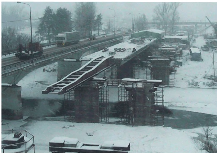
Рисунок Б.7 – Циклическая продольная подвижка пролетного строения моста через р. Москву в Звенигородском районе
