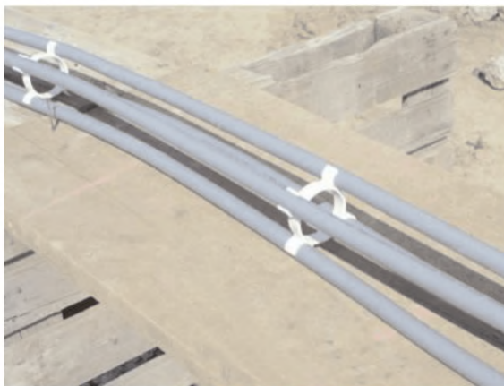
Рисунок 9.2 – Двойная U-образная труба с распорками
