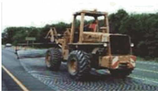
Рисунок 10.1 - Укладка стальной сетки
