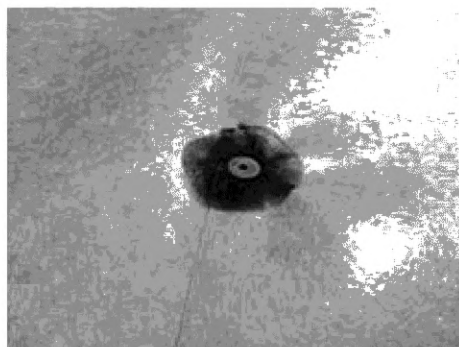
Рисунок 6 — Механическое соединение полотен электропроводящего рулонного материала
