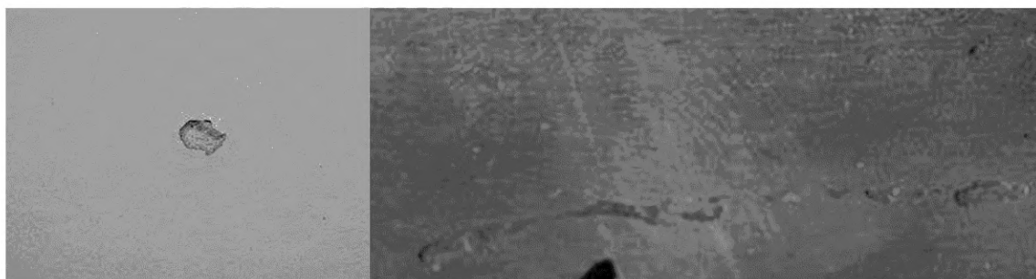
а — внешний вид дефекта в виде углублений
