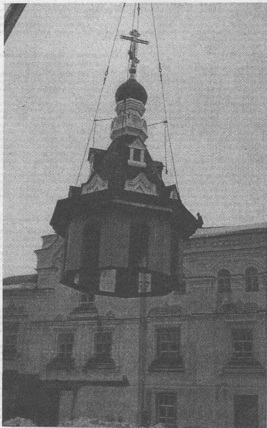
Рис. 59. Подъем готового завершения храма в Свижажске, 2001 г.
