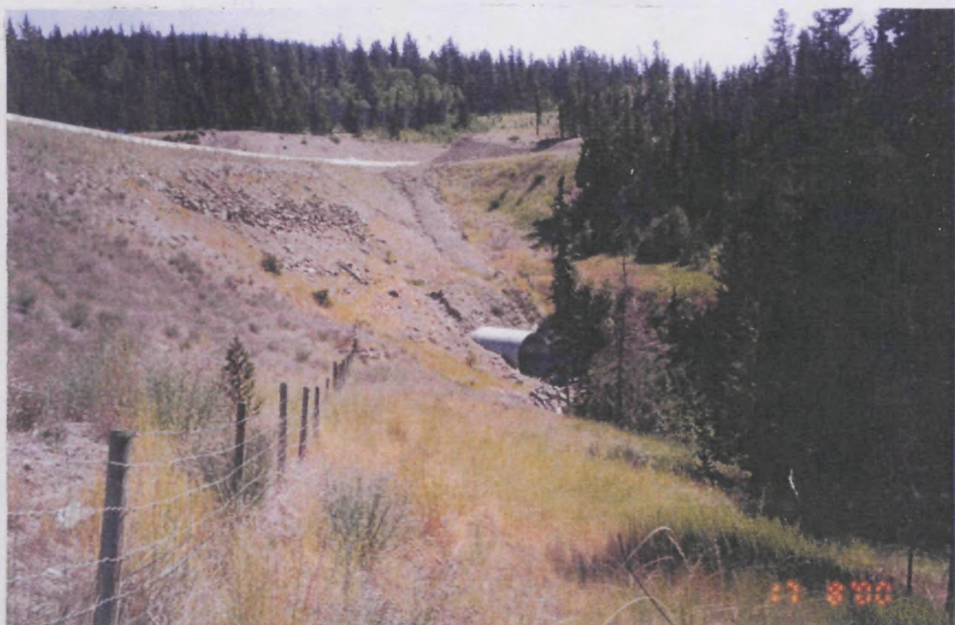
Фото 1. Труба большого диаметра под насыпью автомобильной дороги
