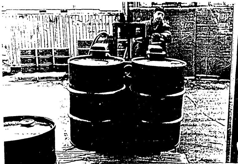
Рис.301.ЗК.1. Транспортирование бочек со складской площадки погрузчиком с торцевым захватом типа ЗГБ. Порт Находка.
