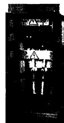
Рис. 1 Камера серии КСО-386М с выключателем нагрузки ВМП-М-10
