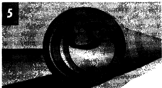
Установка уплотнительного резинового кольца в раструб
