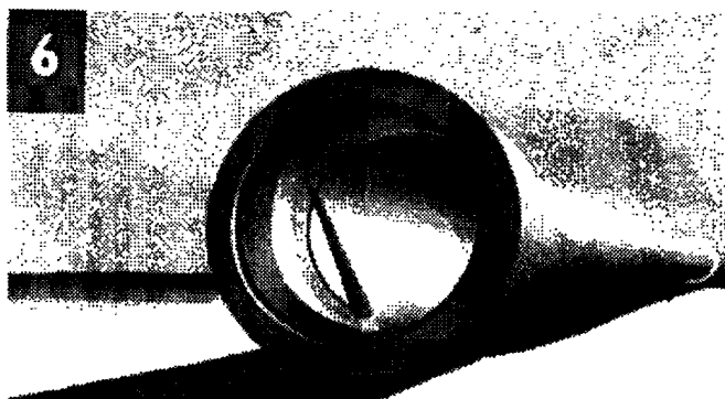
Смазка внутренней поверхности уплотнительного резинового кольца
