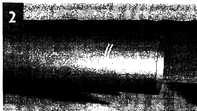
Нанесение линии ограничения на гладком конце трубы
