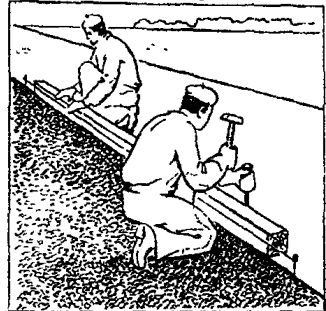
Рис.7. Установка упорного бруса
