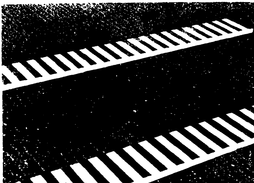
Рис. 5-4 Рифление асфальтового покрытия
