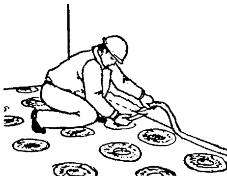
Рисунок 7 – Прирезка полотнищ линолеума по контуру помещения
