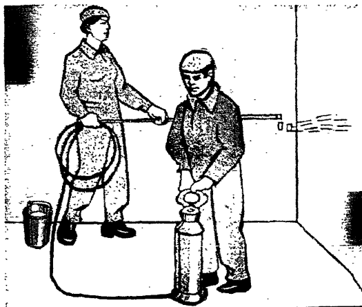
Рисунок 10 – Огрунтовка поверхности стен краскопультом
