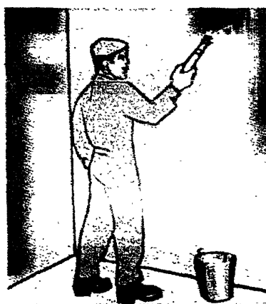
Рисунок 14 – Огрунтовка отшлифованных мест
