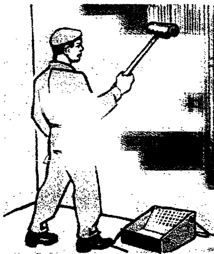
Рисунок 11 – Огрунтовка поверхности стен валиком
