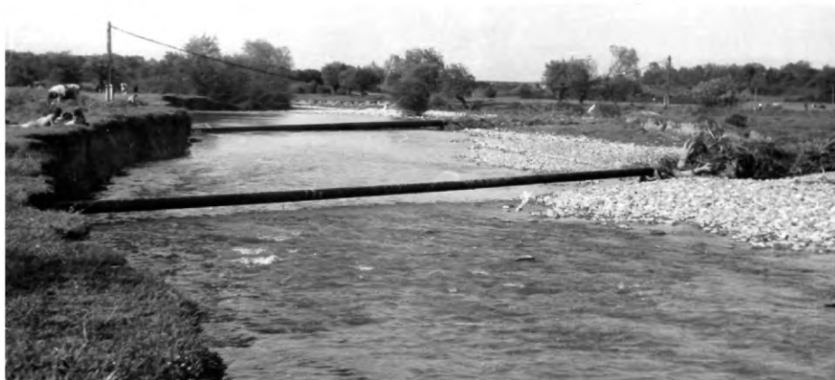
Рисунок Ж.1 — Результаты строительства подводного перехода трубопровода через малую реку без учета ее плановых деформаций
