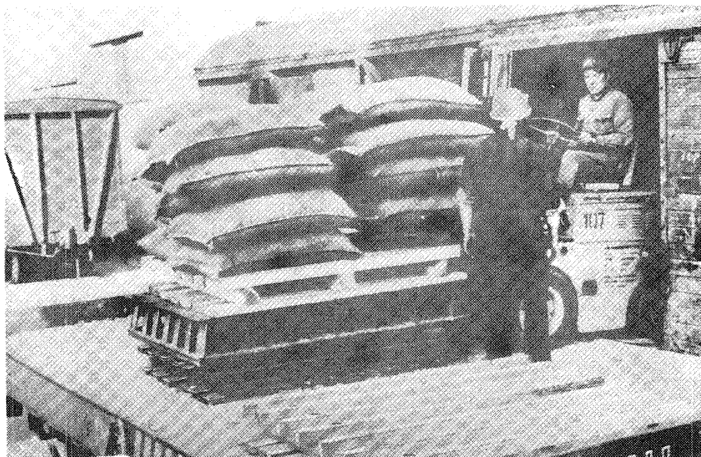
Рис.105.7. Расформирование пакета (на гребенчатом поддоне) при погрузке сахара-сырца в вагон. Порт Николаев.
