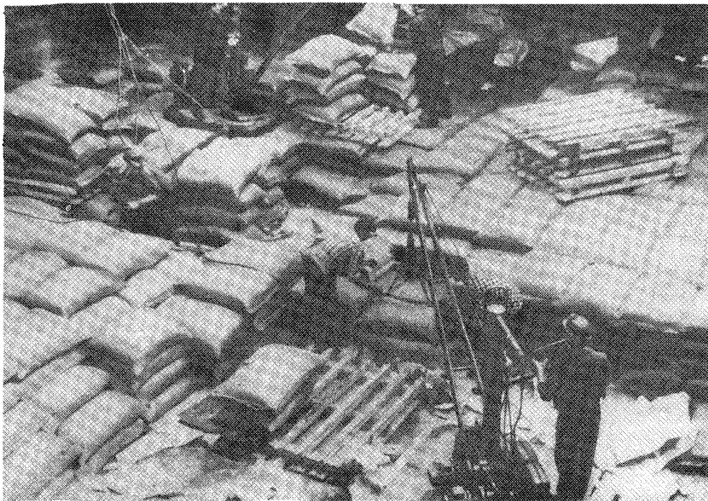
Рис.105.8. Расформирование тремного штабеля с помощью тремных кранов. Порт Николаев.
