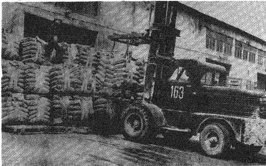
Рис.106.3. Формирование на складе штабеля пакетов цемента (в стропях для пакетирования) погрузчиком, оборудованным рамой с комплектом 2-х кривоых подвесок. Порт Петропавловск-Камчатский.
