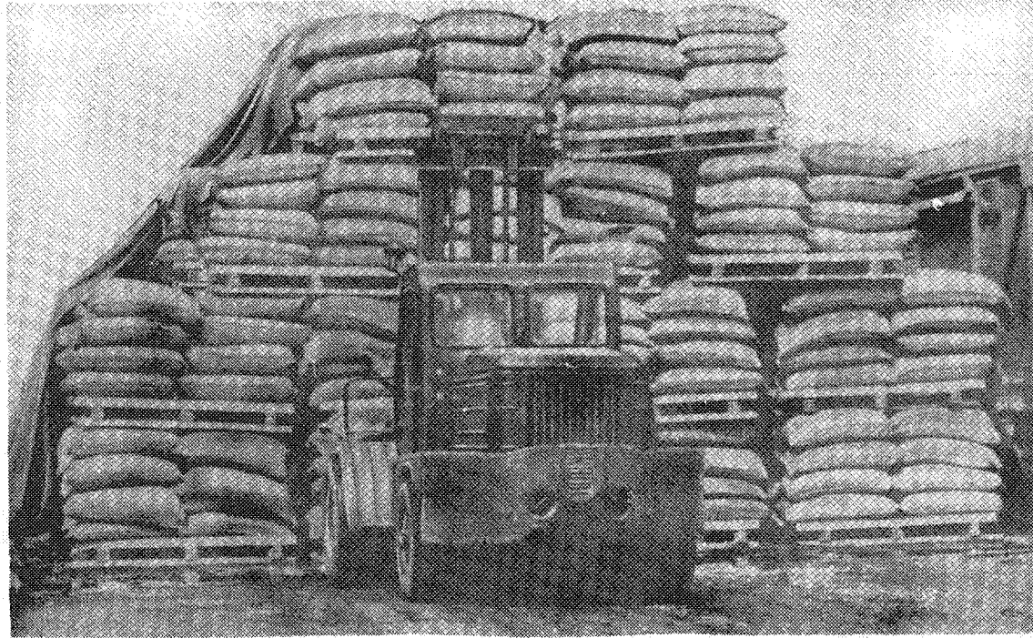
Рис.105.5. Формирование на складе штабеля сахара-сырца в пакетах на гребенчатых поддонах. Порт Николаев.
