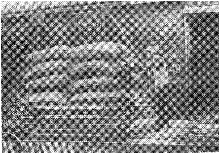
Рис.105.1. Пакет сахара-сырца на гребенчатом поддоне. Порт Николаев.
