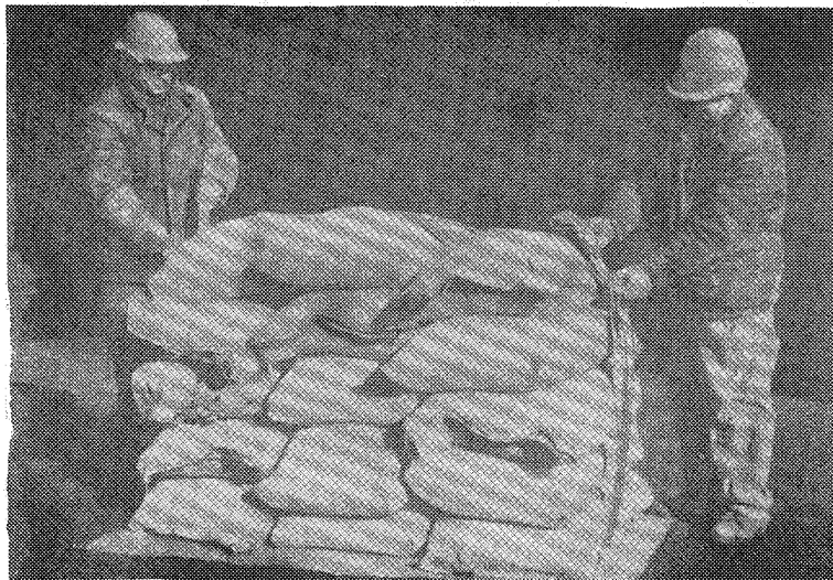
Рис.103.1. Пакет муки в стропах для пакетирования. Порт Владивосток.
