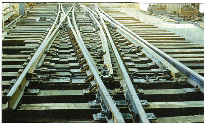
Двойной перекрестный стрелочный перевод типа Р65 марки 1/9. Проект ПТКБ ЦП 2869.00.000
