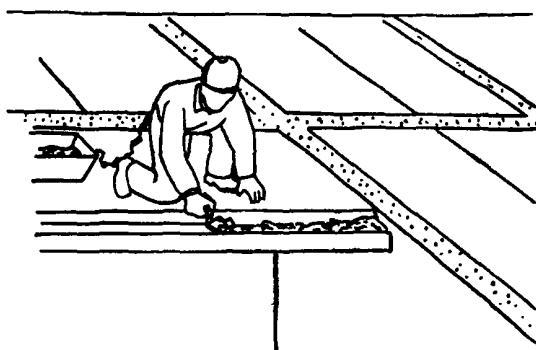
Монтажники  $M_1$  и  $M_2$ , каждый на своем месте, щетками счищают мусор с опорных поверхностей и смачивают их водой при помощи мочальных кистей. Затем они подносят раствор, расстилают его грядками на опорных полках и разравнивают кельмами
