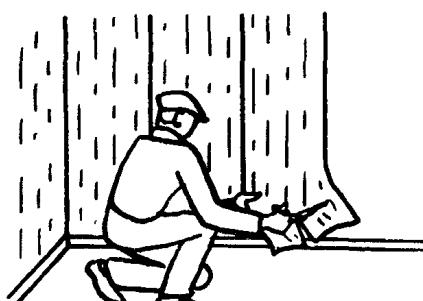
Маляры  $M_1$  и  $M_2$  прирезают наклеенные полотнища обоев в местах примыкания к электроарматуре, выступающим частям конструкций и у пола
