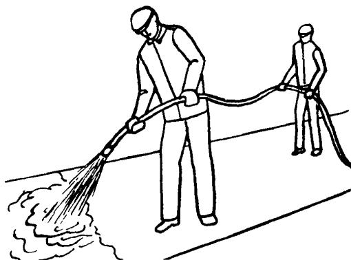
По сигналу кровельщика К<sub>2</sub> машинист включает растворонасос для подачи раствора на рабочее место. Кровельщик К<sub>1</sub> держит шланг двумя руками и, передвигаясь со шлангом назад, наносит раствор на поверхность утеплителя между трубами. Слой раствора должен покрывать маяки на 2–3 мм. Кровельщик К<sub>2</sub> в процессе работы переносит шланг, не допуская его скручивания и перегибов
