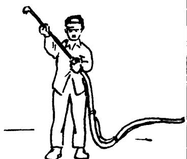
Кровельщик  $K_1$  подсоединяет к одному концу шланга форсунку. Другой конец кровельщик  $K_2$  соединяет с установкой, а затем включает последнюю. Кровельщик  $K_1$  регулирует струю огрунтовочного состава, добиваясь ее равномерности
