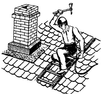
Рис. 14. Вырубка стяжки в примыкании кровли к дымовой трубе
