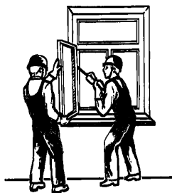
Рис. 40. Снятие оконных переплетов
