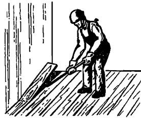
Рис. 31. Отрыв крайней доски
