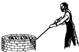
Рис. 46. Разборка кирпичной кладки
