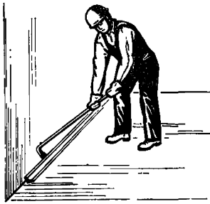
Рис. 30. Отрыв плинтуса от стены
