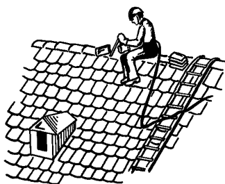
Рис. 12. Разборка коньковой черепицы
