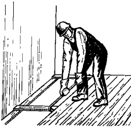
Рис. 32. Отрыв соседних с крайней досок
