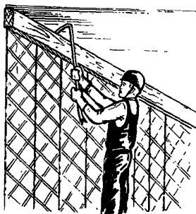
Рис. 37. Отрыв брусков обвязки
