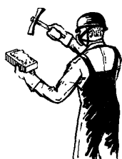
Рис. 47. Очистка кирпичей от раствора
