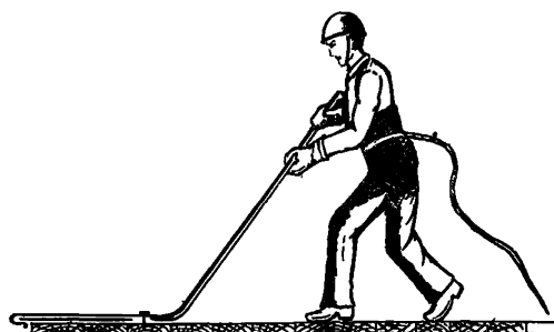
Рис. 9. Снятие карнизного свеса
