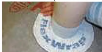
Рисунок П.7 – Герметизация мест примыкания пароизоляции AirGuard® Sd5 к выступающим элементам лентой Tyvek® FlexWrap
