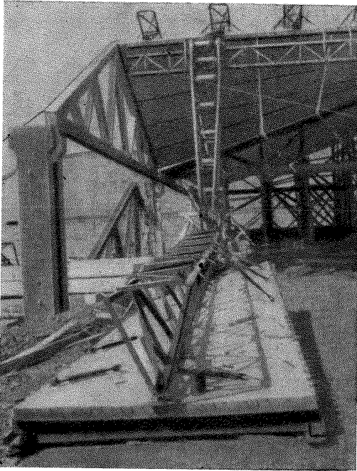
Рис. 7, а. Укрупненный монтажный блок длиной, равной половине пролета оболочки двоякой отрицательной кривизны
